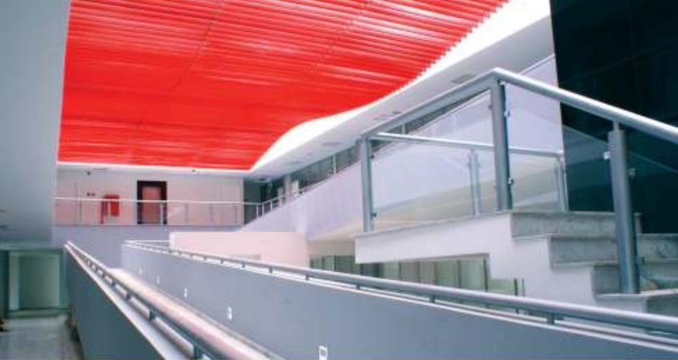
Composto por painéis verticais com 100mm ou 200mm de altura, com boa absorção acústica. Possibilitam acoplar os sistemas de comunicação visual, sonorização, sprinklers e câmeras. Pode-se também formar planos reticulados que determinam o pé direito em grandes ambientes.
