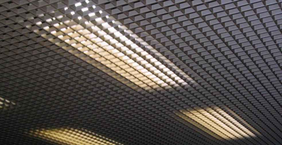
Composto por grelhas quadriculadas de 625mm x 1250mm, montadas com perfis tipo "U" com 10mm de base por 25 ou 35mm de altura.
