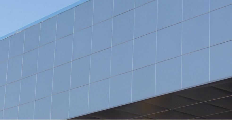
Composto por painéis modulares com arestas chanfradas, disponíveis nas medidas padrão de 500 x 500mm e 625 x 625mm, ou outras sob consulta. Sustentados lado a lado em junta seca e fixados sob pressão à estrutura oclusa formando plano contínuo de visual reticulado. A remoção dos painéis para o acesso às instalações sobre o forro é feita com a utilização de uma espátula. O Sistema Clip-in pode ser aplicado em Forros e Fachadas.
