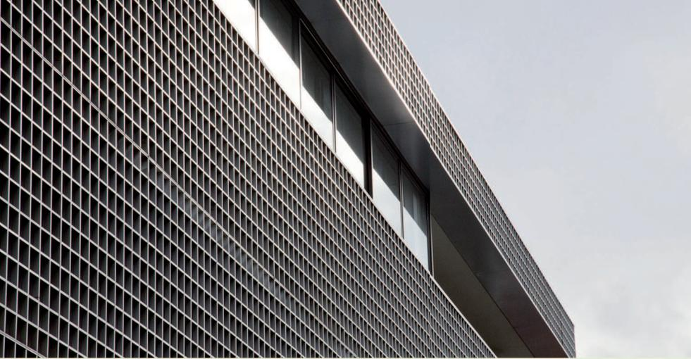
Composto por grelhas que, unidas através de conectores especiais e perfis perimetrais, formam painéis de acabamento em dupla face com diversas opções de malha e modulações. As células dos painéis podem ser quadradas ou retangulares de acordo com seu projeto.
