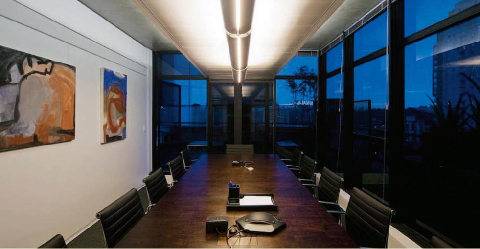
Composto por bandejas quadradas ou retangulares apoiadas lado a lado em juntassecas sustentadas por estrutura oclusa formando planos perfeitamente lisos. O sistema permite remoção das bandejas com facilidade para acesso aos equipamentos sobre o forro.
