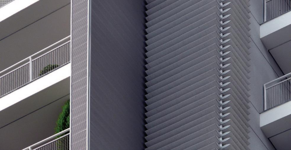
Sistema composto por painéis com formato de meia asa de avião que podem ser montados separadamente ou em duplas e com espaçamentos variáveis. Como forro, pode ser perfurado e preenchido com mantas para absorção acústica.
