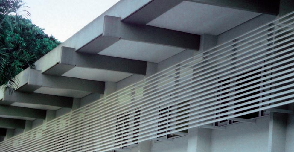
Brise de ótimo custo-benefício composto por painéis lineares encaixados ao porta-painel brise, em duas opções de angulação: 45° e 60°, podendo ser lisos ou perfurados.
