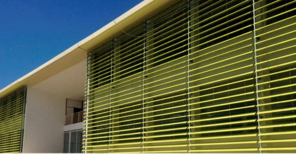
Composto por painéis curvos retráteis com 288 mm de largura fixados sobre eixos tubulares de alumínio, unidos através de uma haste que permite o acionamento em conjunto. Os painéis AS288 podem ser microperfurados, permitindo assim a visualização do ambiente externo sem perda do controle de insolação e da privacidade.
