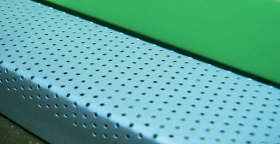
Composto por painéis lineares com 4 opções de largura fixados ao porta painel autotravante formando planos contínuos que podem ser combinados. Os painéis podem ser lisos ou perfurados
