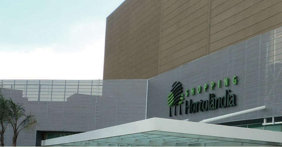
Composto por painéis ondulados tipo lambri com 270mm de largura útil e comprimento variável conforme projeto. O revestimento MW270 pode ser aplicado das mais variadas formas, posições e cores. Os painéis podem ser lisos ou perfurados.
