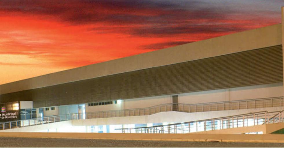
Veneziana fixa de ventilação permanente composta por painéis lineares VP115. A maior sobreposição dos painéis VP115 proporciona maior proteção contra chuvas.
